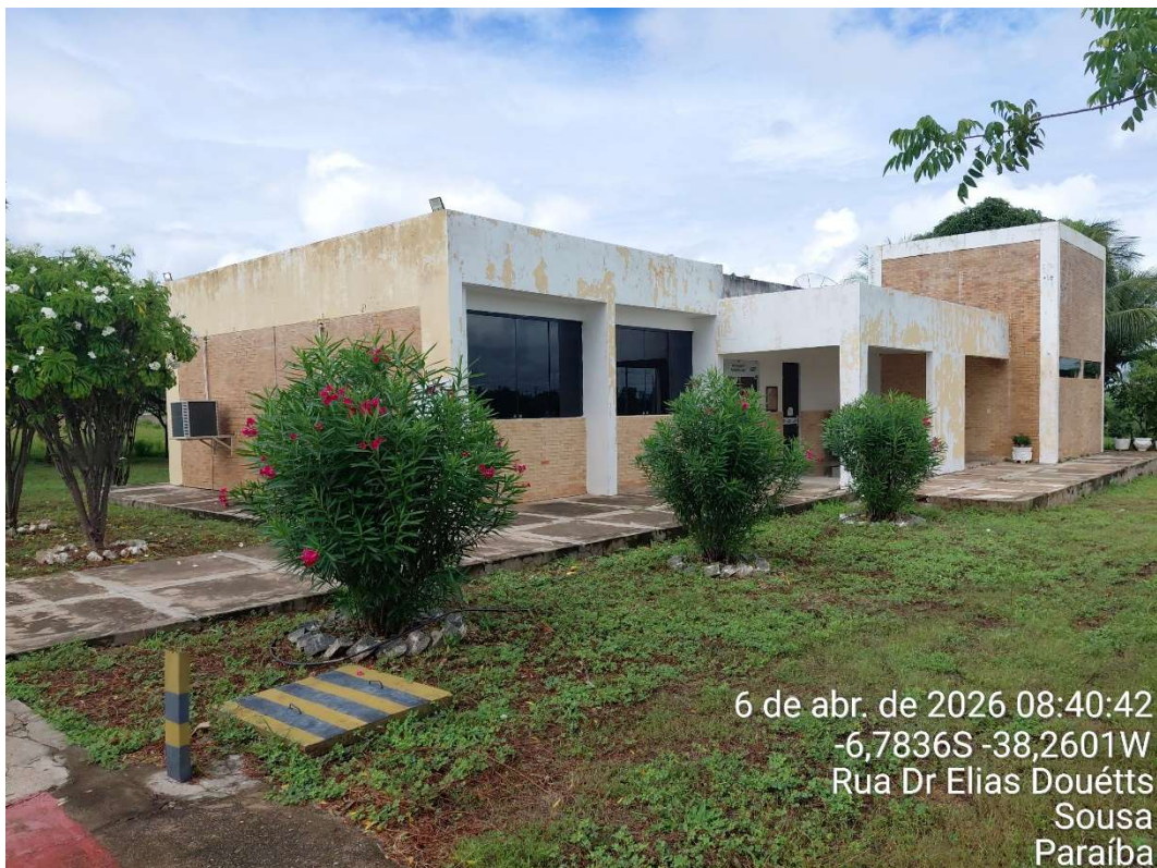
Foto 3- Fachada do Restaurante Universitário- UFCG/CCJS- Fonte: O AUTOR
