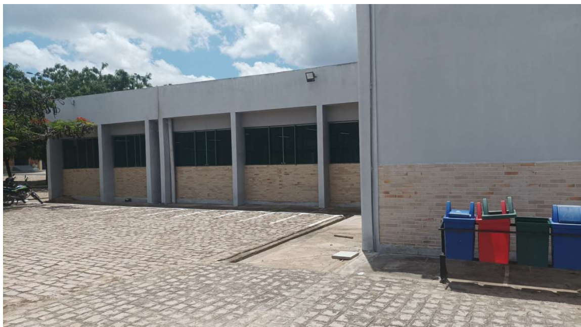
Foto 7- Fundos da Edificação. Fonte: O AUTOR
